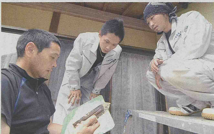
材料の練り具合を厳しくチェックする。(中央が牛丸さん)
